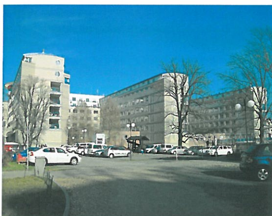
Vnitřní areál CONSTRUCTION a.s.
